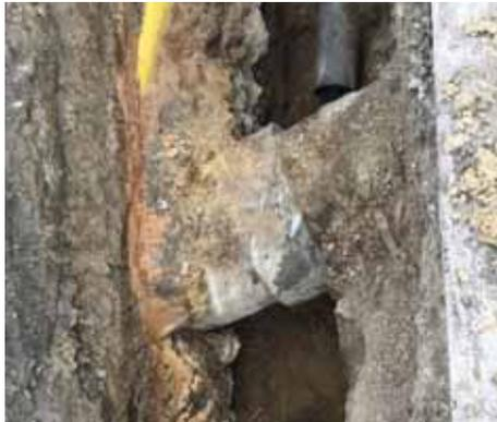
Eine besondere Herausforderung war aber die Sanierung der gebrochenen Leitung, lag die defekte Stelle genau unter dem Grünzer Kanalrohr und unmittelbar neben 2 Gasleitungen.
