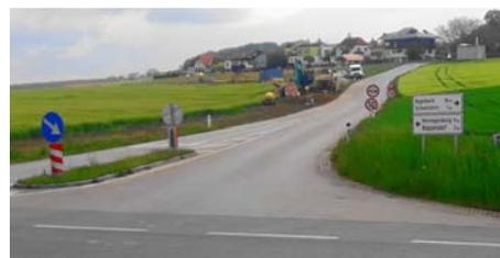
In Flinsdorf und in der Hainer Straße werden mit Unterstützung vom Land NÖ Fahrbahnbegrenzungen errichtet und Randsteine gesetzt, bevor auch hier die Verschleißschicht aufgetragen wird.
