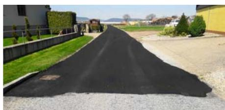
In Zagging wurde der Westring mittels neuer 2-Komponententechnik saniert, ebenso einige Abschnitte auf abschüssigen Güterwegen in Merking.
